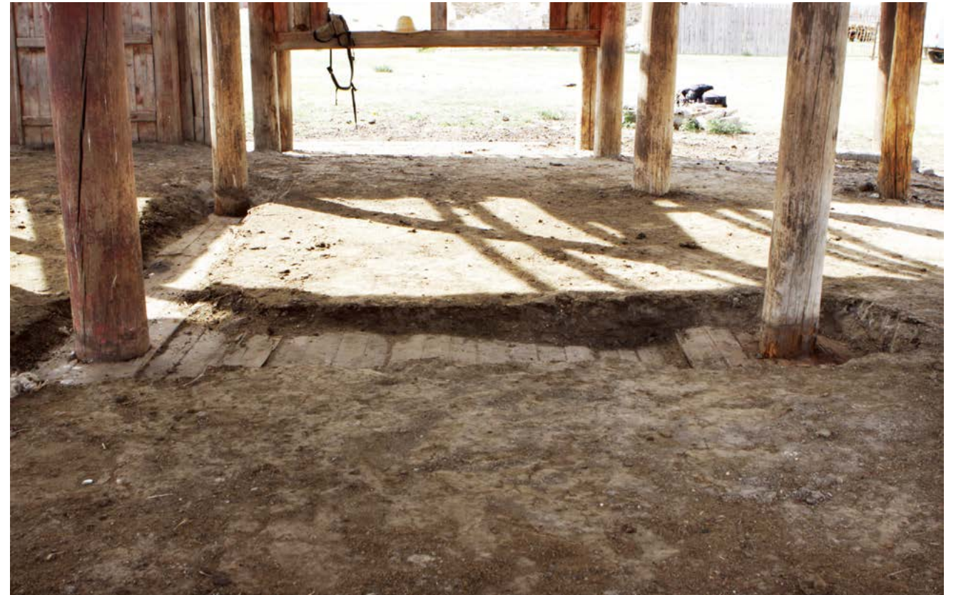
내부 바닥 마루 트렌치 2
