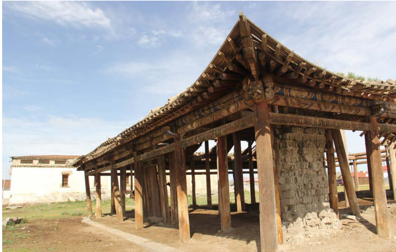
정면 공포대 전경(남동 → 북서)
