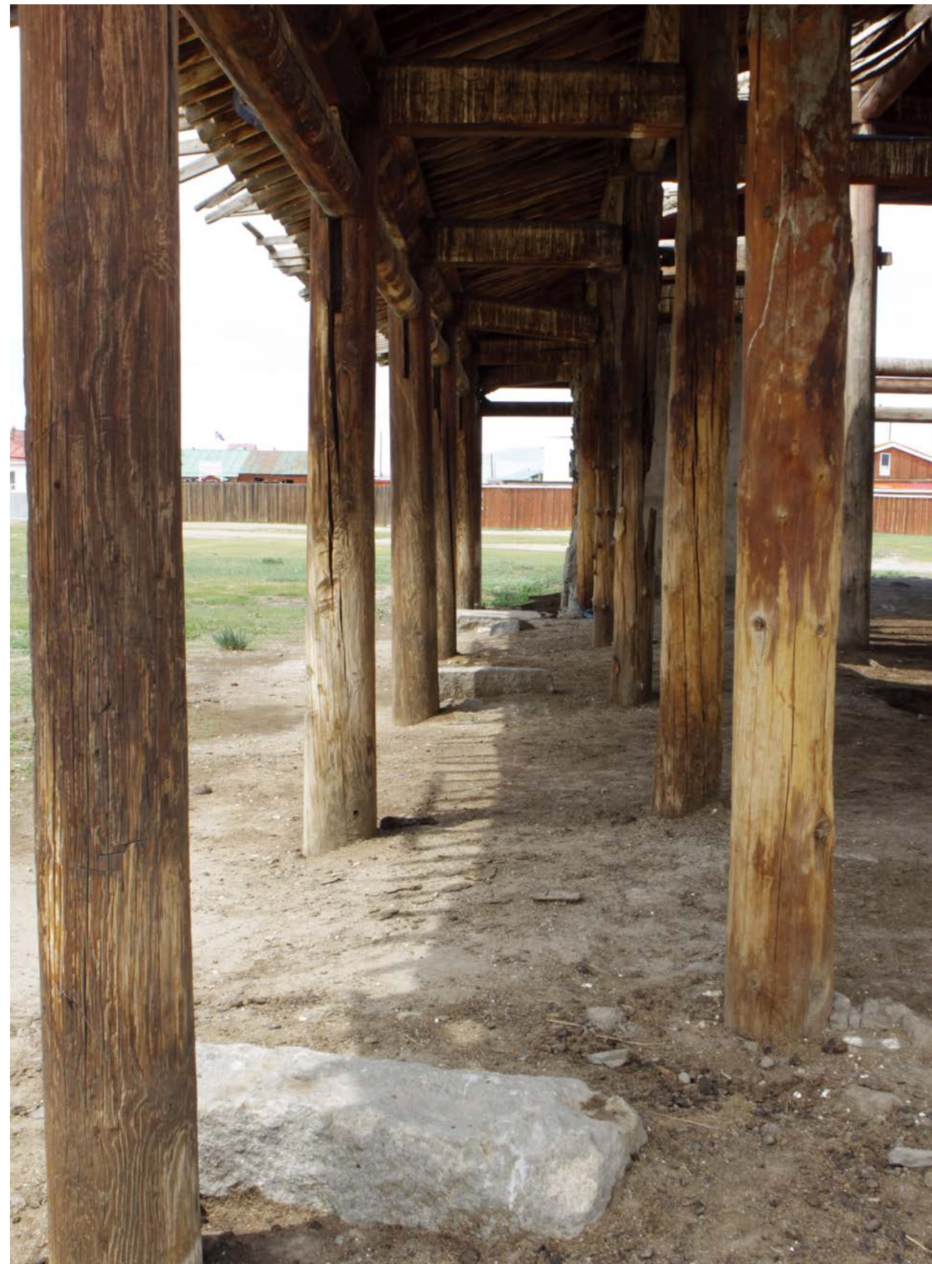
좌퇴칸 내부 전경 (남 → 북)
