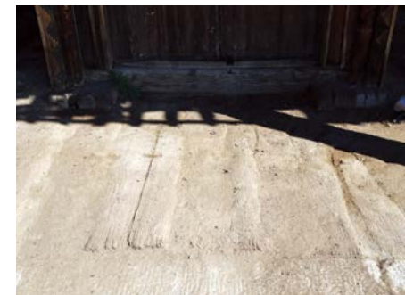
출입구 전면 목재 포장
