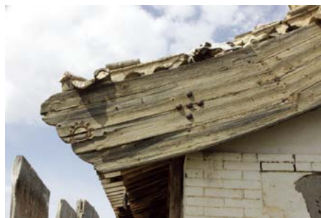
Дээврийн хажуугийн хөвөө модны үзүүрийн чимэглэл, төмөр товруу
