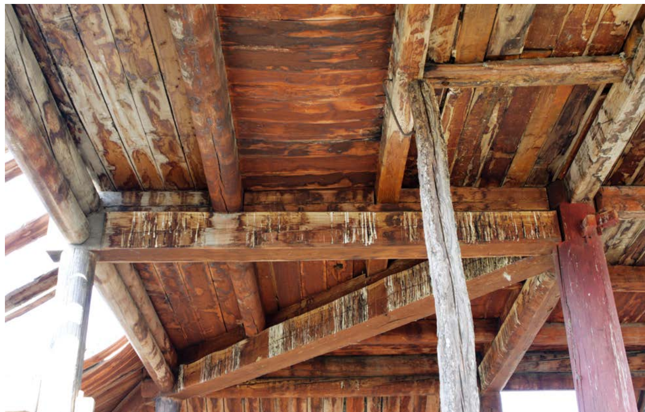
서남모서리 상부 가구 전경 2
