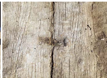
Эрвээхий хэлбэрийн шаантаг модоор холбосон байдал
