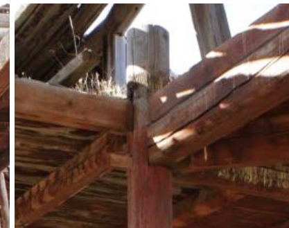
Өндөр баганын дээд үзүүрийн зангидан холбосон байдал
