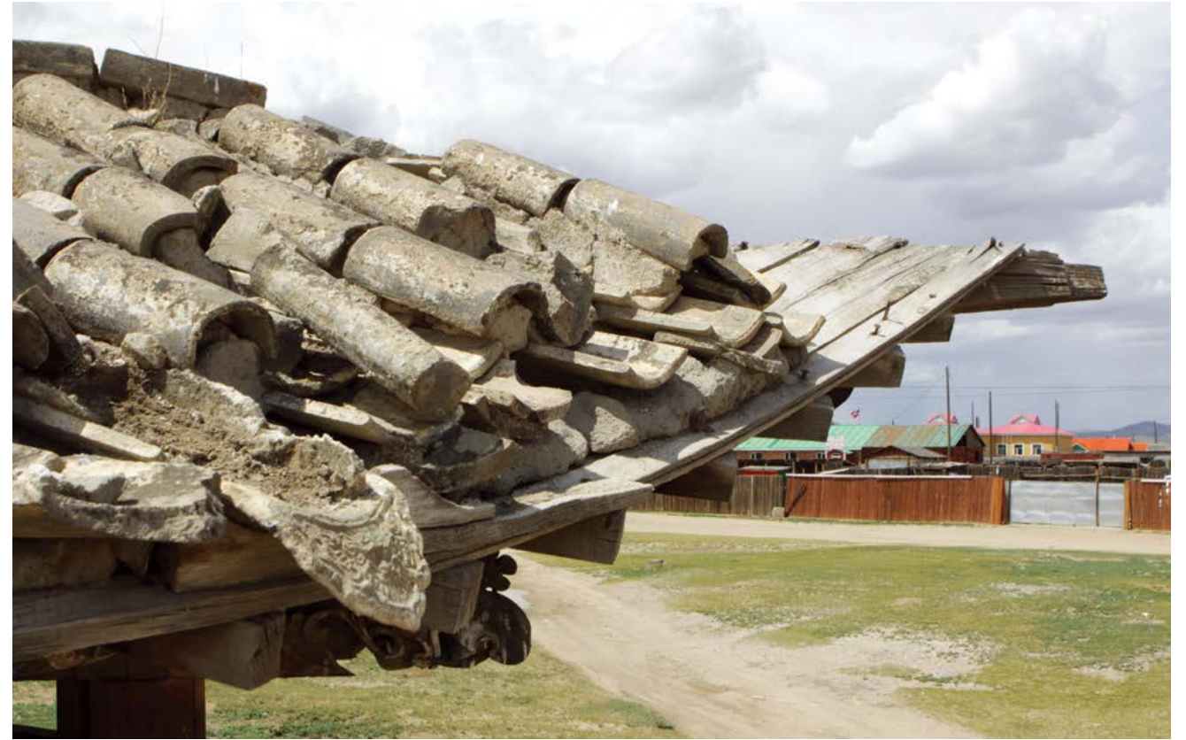
동북 모서리 지붕 마감 현황
