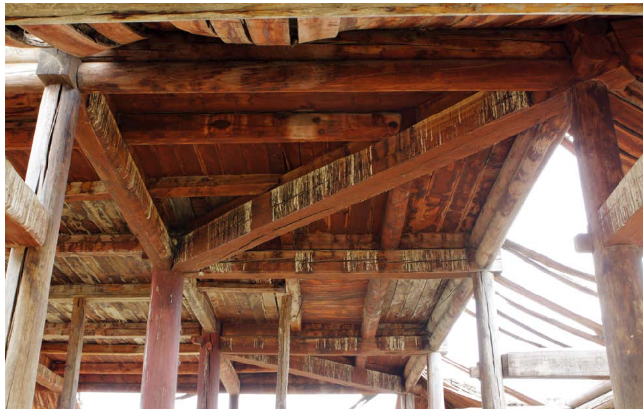
서남모서리 상부 가구 전경 1
