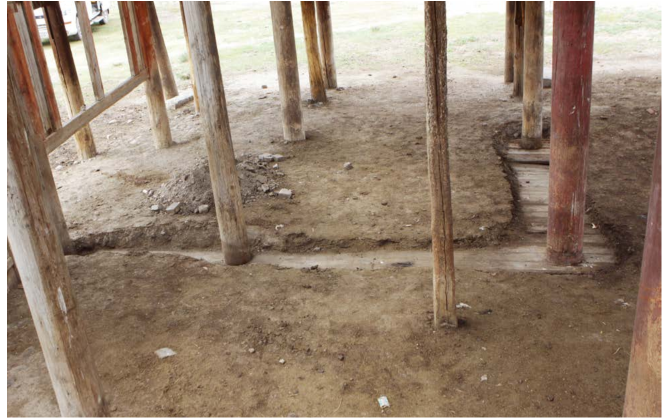
내부 바닥 마루 트렌치 1
